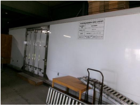
積替保管施設
