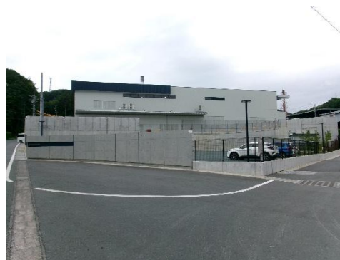
新焼却炉施設全体
