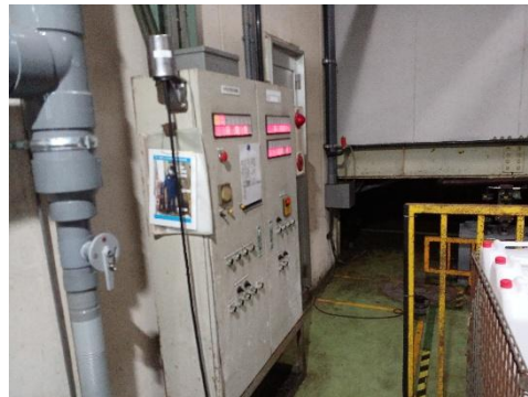
側溝PH監視盤
