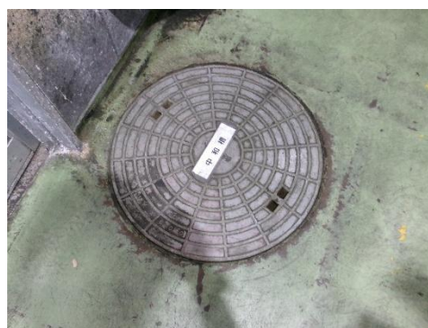
中和施設地下ピット
