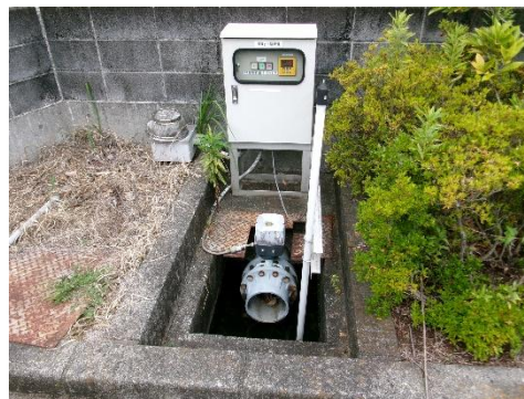
側溝PH監視盤
