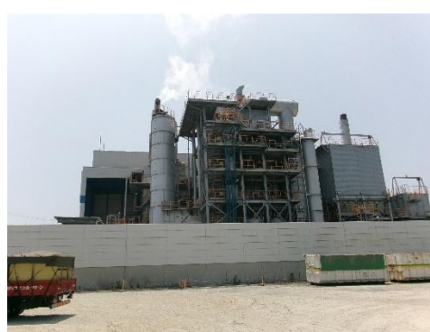
焼却施設全体
