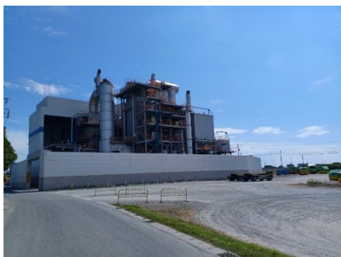
焼却施設全体
