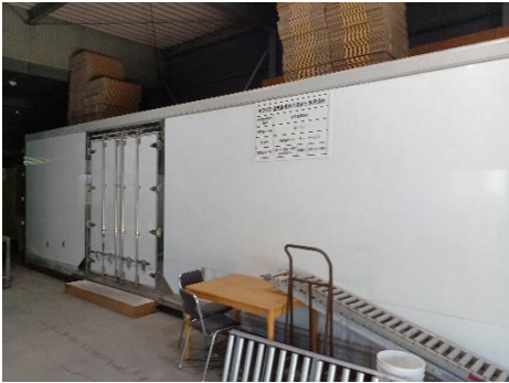
積替保管施設
