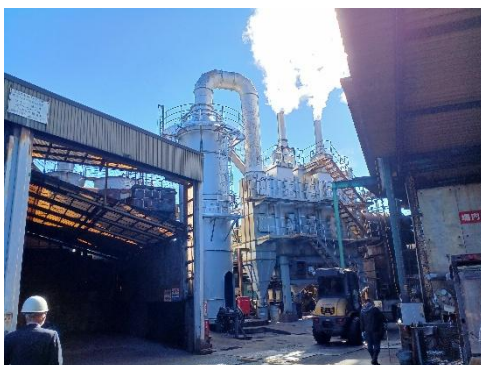
焼却炉の全景
