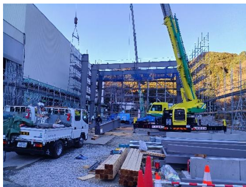
破碎施設建設工事
