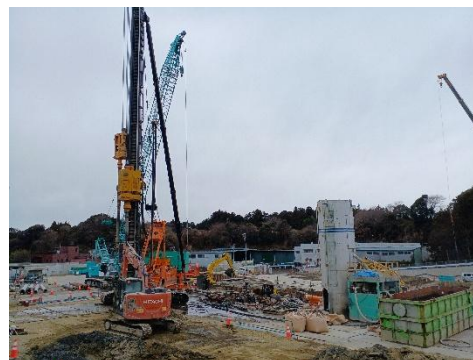
新焼却施設建設工事
