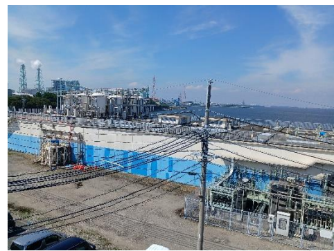
浸出液処理施設
