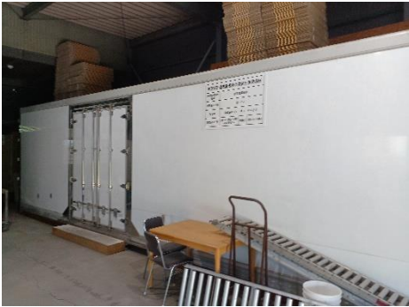
積替保管施設
