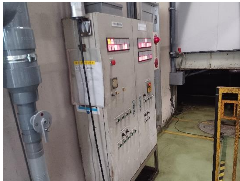
側溝PH監視盤
