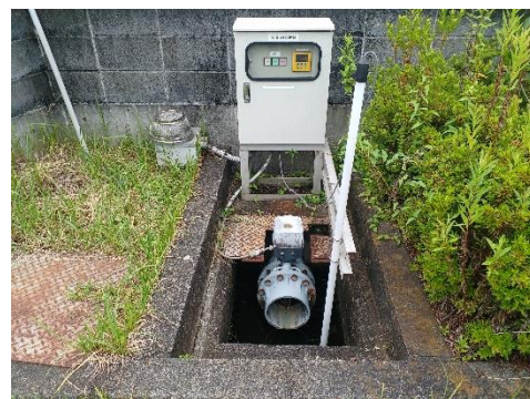
側溝PH監視盤
