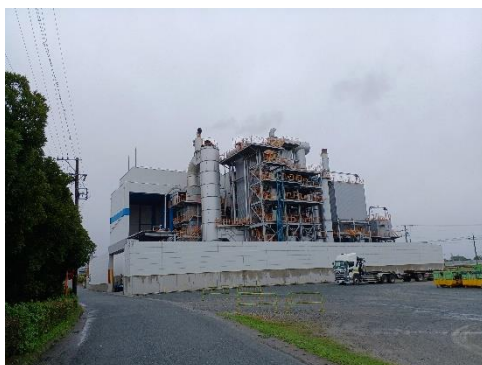
焼却施設全体
