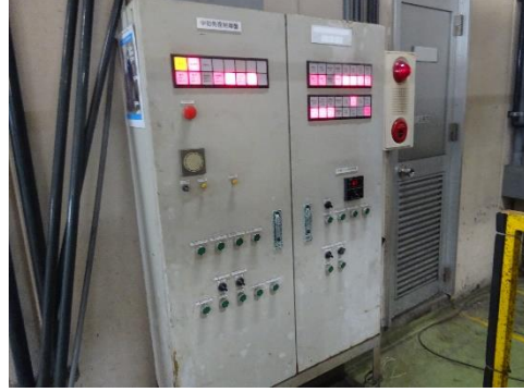
側溝PH監視盤
