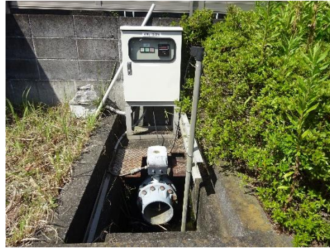
側溝PH監視盤
