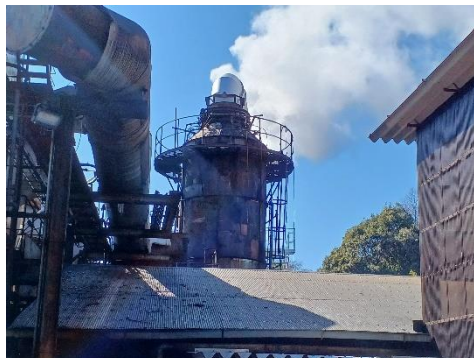
回収工事予定水管
