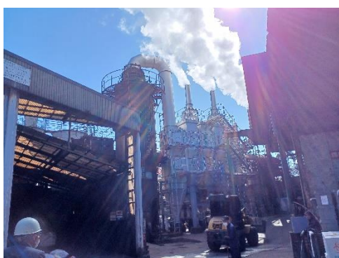
焼却炉の全景
