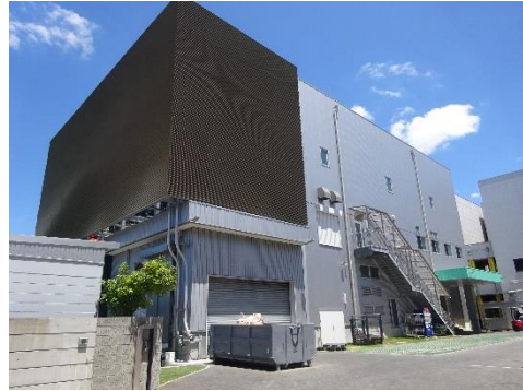
焼却施設の全景
