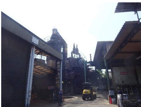
焼却炉の全景
