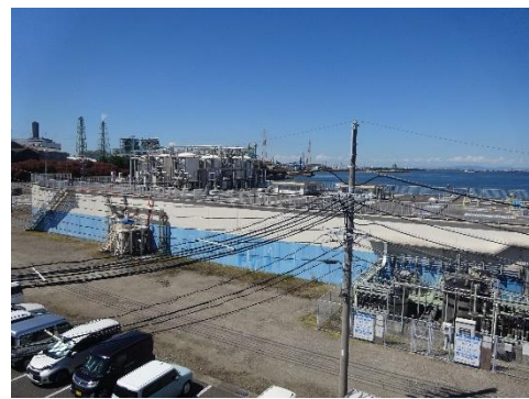
浸出液処理施設
