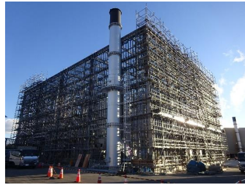
新焼却施設建設中
