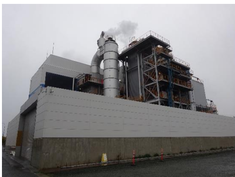
焼却施設全体
