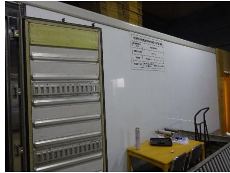
積替保管施設
