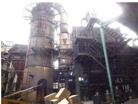
焼却炉の全景
