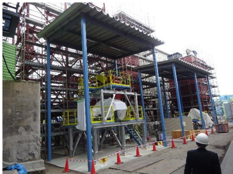
新焼却施設建設中
