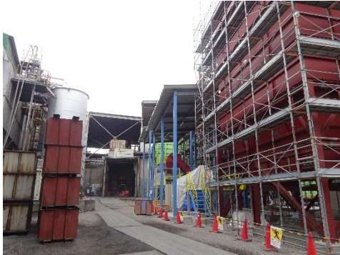
新焼却施設建設中
