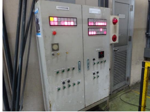
側溝PH監視盤
