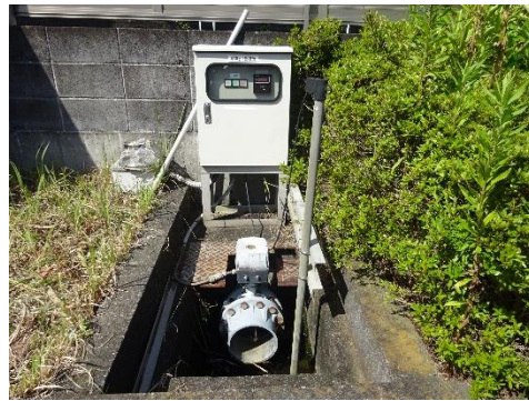
側溝PH監視盤
