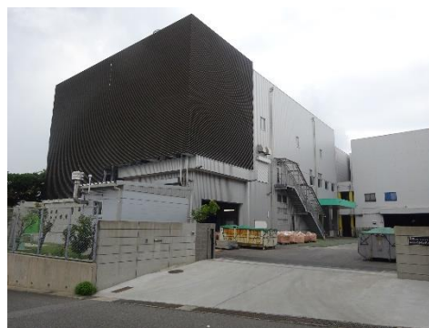
焼却施設の全景
