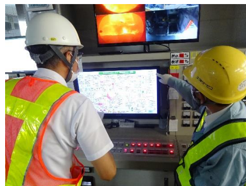
焼却炉のデータ確認
