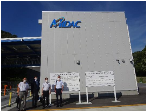
奥山の杜クリーンセンター管理事務所前
