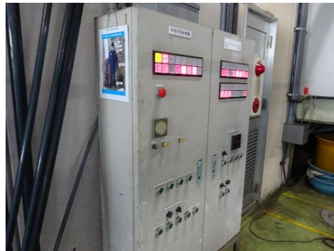
側溝PH監視盤
