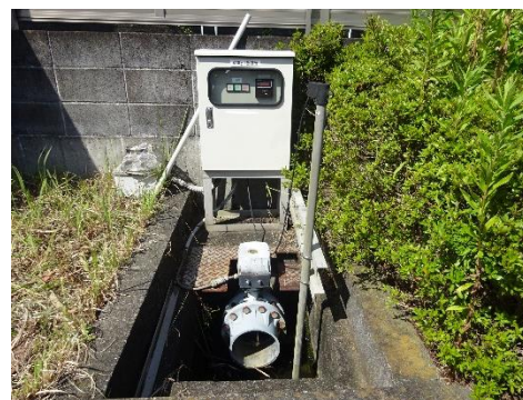
側溝PH監視盤
