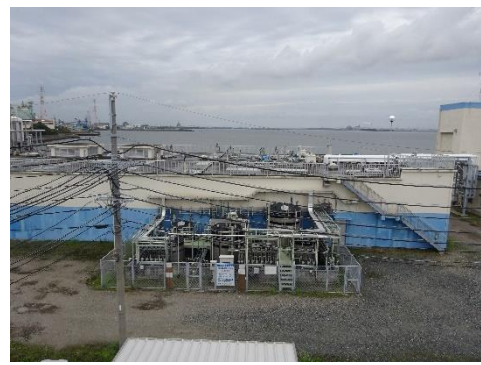
凝集沈殿処理施設
