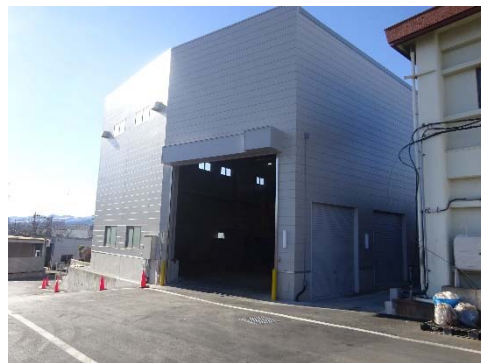
破砕施設の全景
