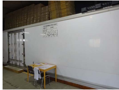
積替保管施設
