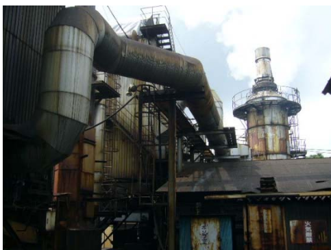
焼却炉の全景
