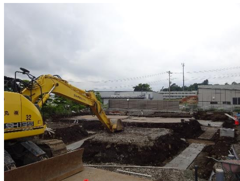
縦型破砕機建設中
