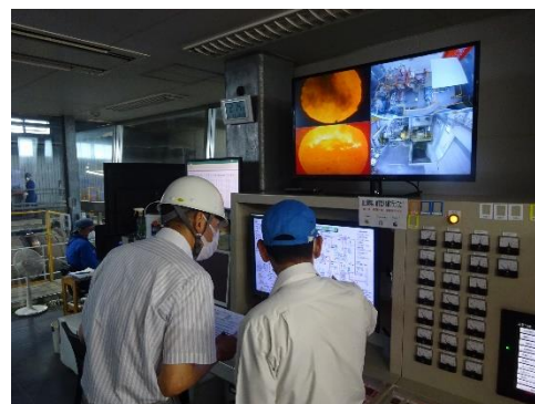
焼却炉のデータ確認
