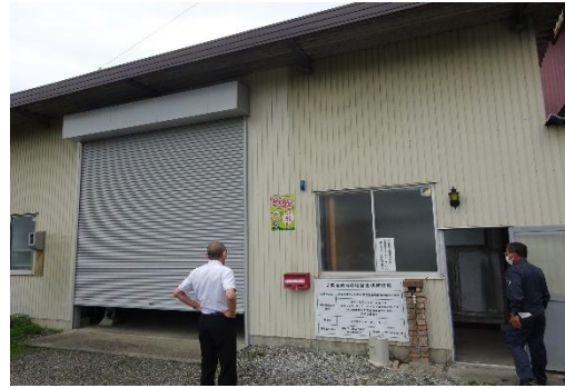
積替保管施設
