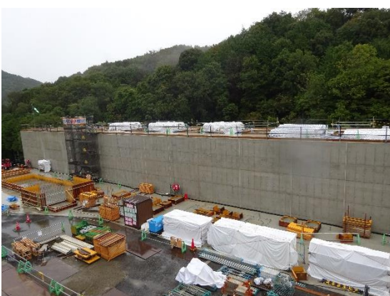
建設中の新水処理施設
