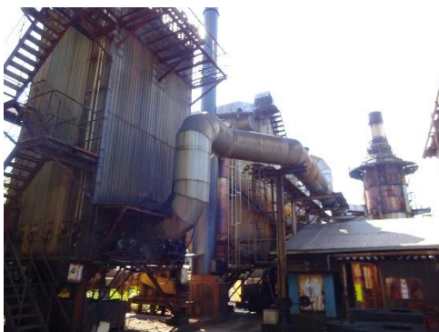
焼却炉の全景
