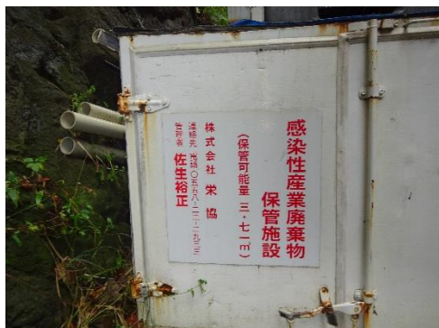
積替保管施設
