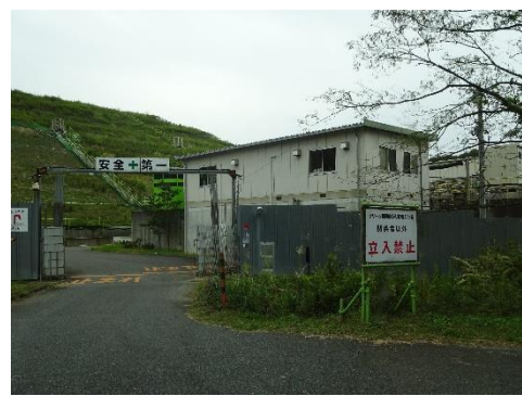
浸出水処理施設
