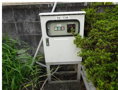
側溝PH監視盤
