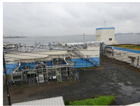
凝集沈殿処理施設
