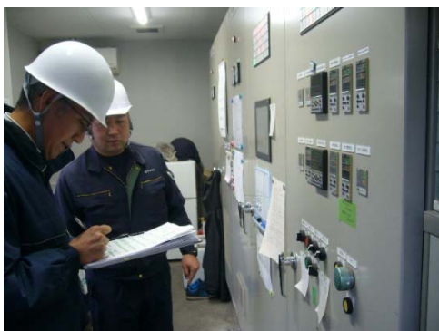
焼却炉のデータ確認
