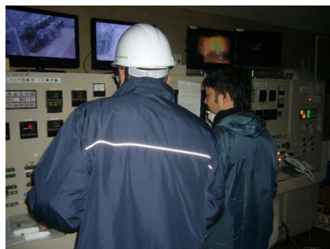
焼却炉のデータ確認
