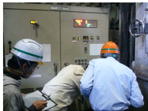
焼却炉のデータ確認（1）
