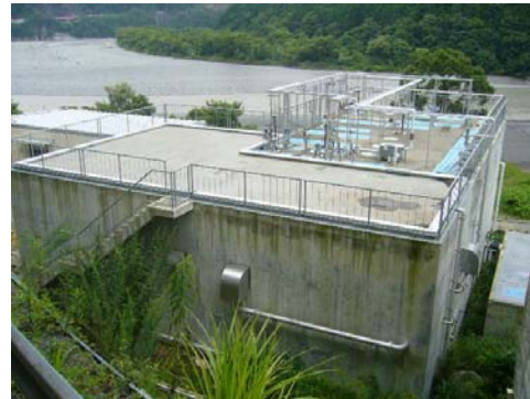
廃水処理施設
