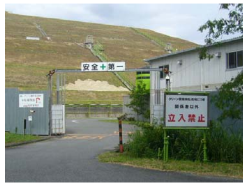
浸出水処理施設
